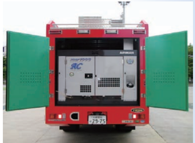
写真4 積載庫内に固定されたエアマン
